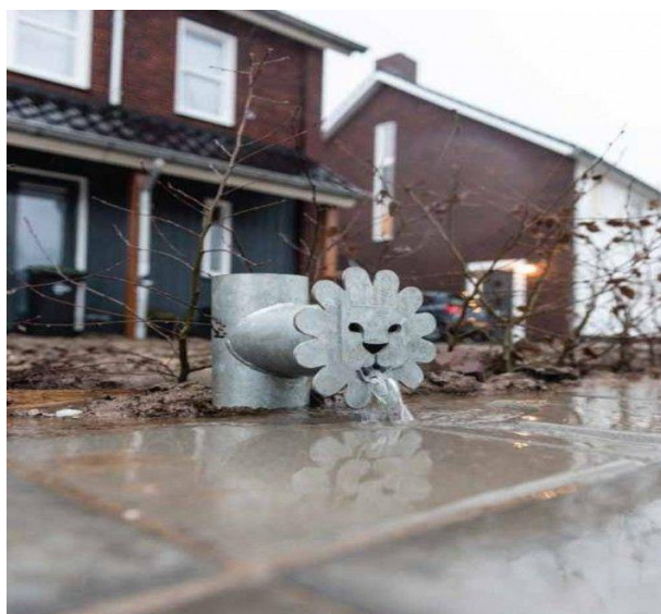
Figuur 3; Noodoverloop infiltratievoorziening (burojet designstudio, 2018)
