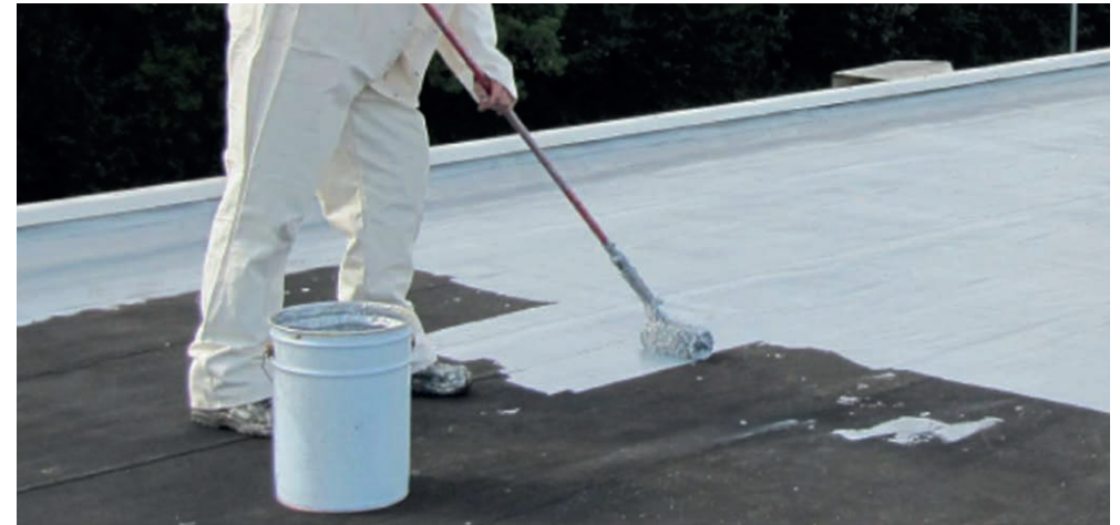
Figuur 4: Bitumineuze dakbedekking wordt gecoat om verkleuring van het afstromend hemelwater en opwarming van het materiaal te verminderen.
