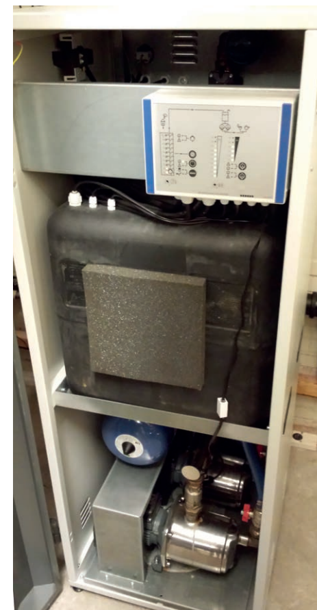
Figuur 15: Hemelwatersysteem- hybride pompsysteem
