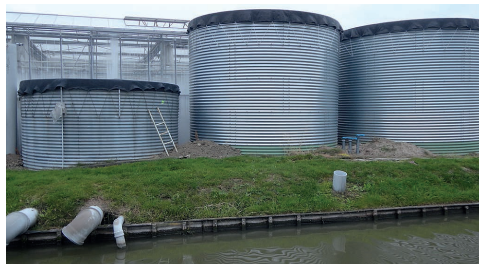
Figuur 22: Door de grote dakoppervlakte kunnen kassencomplexen veel hemelwater opvangen en benutten voor de teelt.
